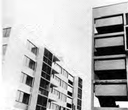
1961-62. Edificios Arauco y Lanalhue, Concepción, con E. Duhart H.
