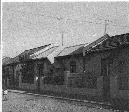
Estas viviendas, en el Barrio Cruz, continuas y con un pequeño antejardín, logran crear un espacio urbano a escala del individuo y propicio para una vida urbana vecinal tranquila.
