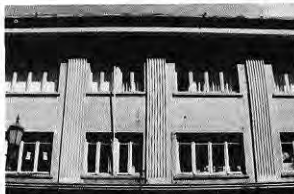
Fig. 222. Fachada 2º piso, Paseo Peatonal, calle Aníbal Pinto, Concepción.
