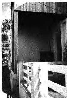
Fig. 231. Detalle de columna en madera. Vivienda en calle Sales. Concepción.
