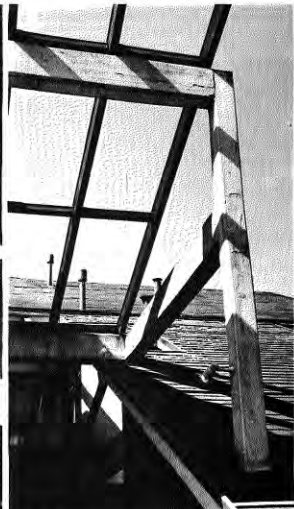
Fig. 238. Detalle de columna. Vivienda calle O'Higgins. Concepción.
