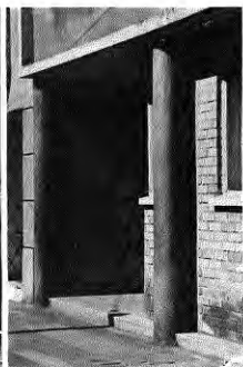
Fig. 234. Detalle de columnas de acceso en calle Arbul Peto. Concepción.
