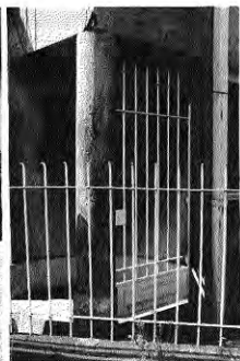
Fig. 232. Detalle de columna. San Martín esquina Diagonal P.A. Cerda. Concepción.
