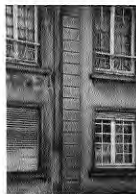
Fig. 221. Detalle columna vivienda en calle Orompelo.
