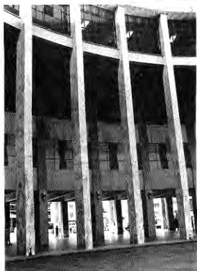
Fig. 264. Columnata Central, Palacio de los Tribunales.
