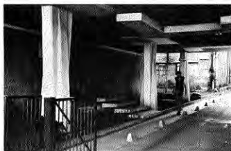
Fig. 243. Detalle de columnas. Edificio en calle Aníbal Pinto. Concepción.
