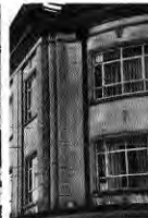
Fig. 225. Detalle columna. Freire esquina Aurelio Manzano.
