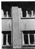
Fig. 223. Detalle columna Edificio Paseo Peatonal.
