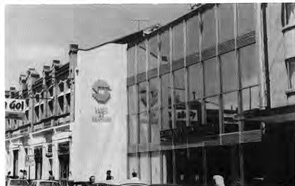
Fig. 229. Edificio Banco de Santiago, Concepción.
