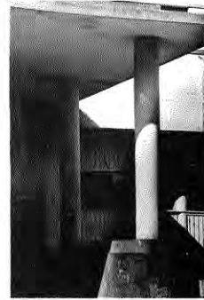
Fig. 253. Mercado Municipal de Concepción: columna en acceso calle Rengo.
