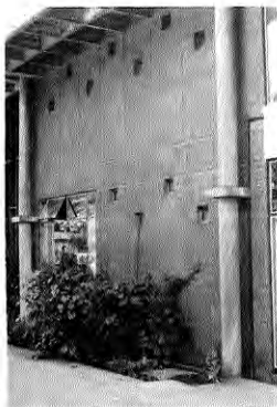
Fig. 260. Detalle de bajada de aguas lluvia. Remodelación Central.
