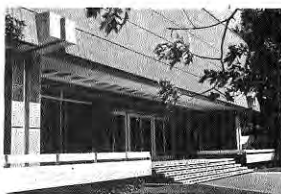
Fig. 270. Casa del Arco.
