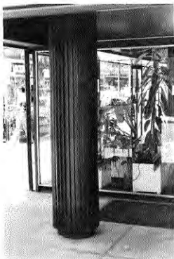
Fig. 261. Columna de hormigón armado revestida en madera. Remodelación Central.
