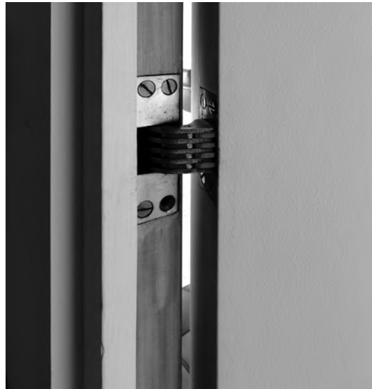
Figura 23. Bisagra de la puerta del baño de servicio. Fotografía: los autores, 2013
