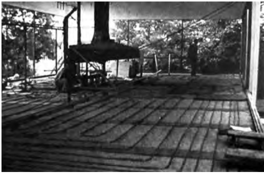
Figura 4. Construcción del piso radiante
