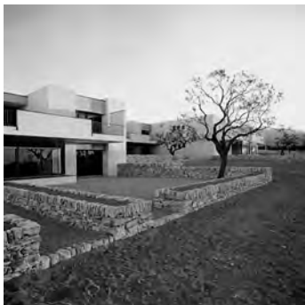
Figura 19. Viviendas para peritos del poblado HIFRENSA. Fuente: AHC.
