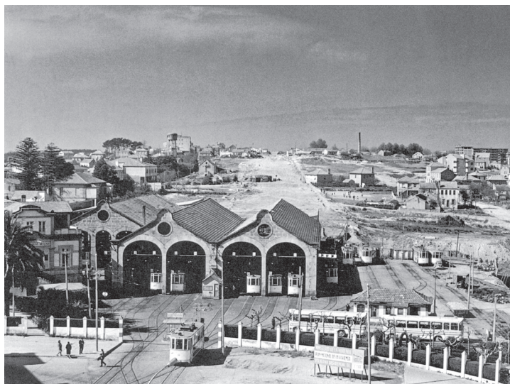
Figura 4. Antiguas cocheras del tranvía en Las Traviesas (Vigo, 1968). Al fondo, el futuro polígono de Coya. Fuente: García Castro, Vigo por Magar
