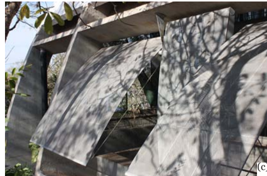
Fig.3 (a) Luminárias pedestais nos postos de trabalho, (b) fechamento em vidro da fachada noroeste, beiral e parte interna dos brises e (c) e vista externa dos brises móveis de chapa perfurada.
