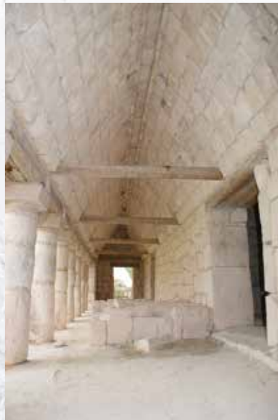
Fig. 1. Bóveda maya con rollizos de madera que semejan el balo, Uxmal Fuente: Tomada por el autor, 2009
