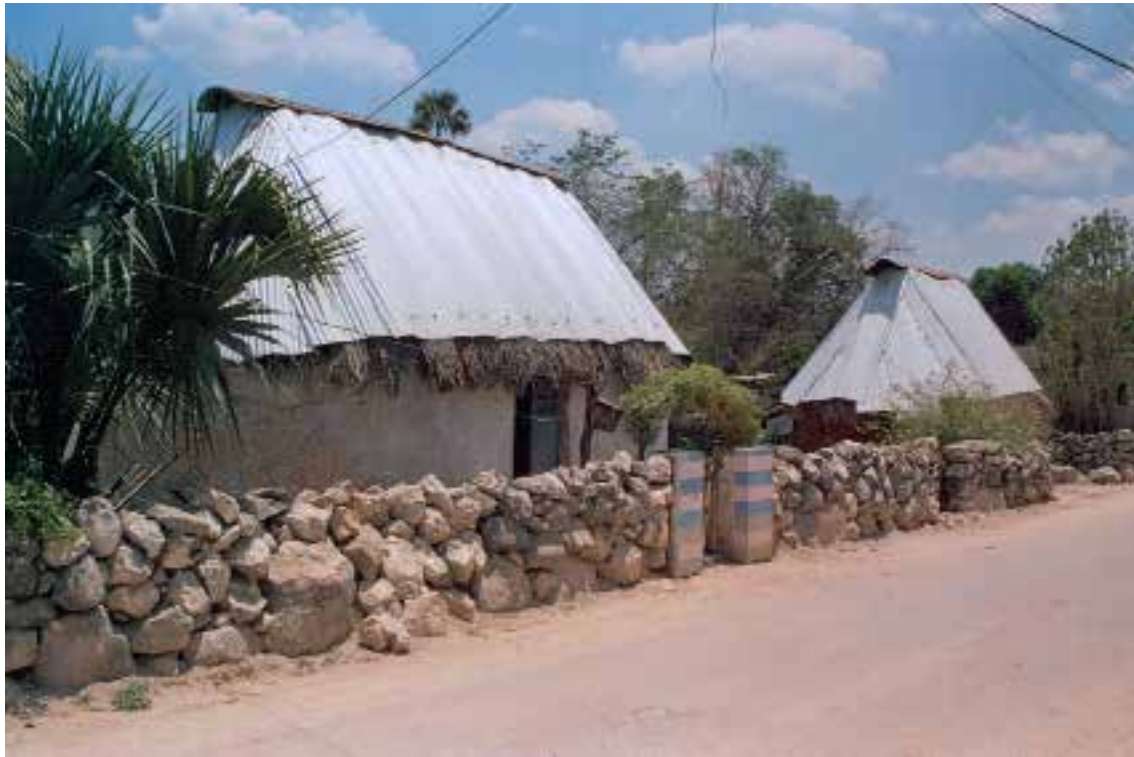
Fig. 5. Viviendas vernáculas con láminas de zinc cubriendo el techo de palma. Nunkiní, Campeche Fuente: Tomada por el autor, 2002
