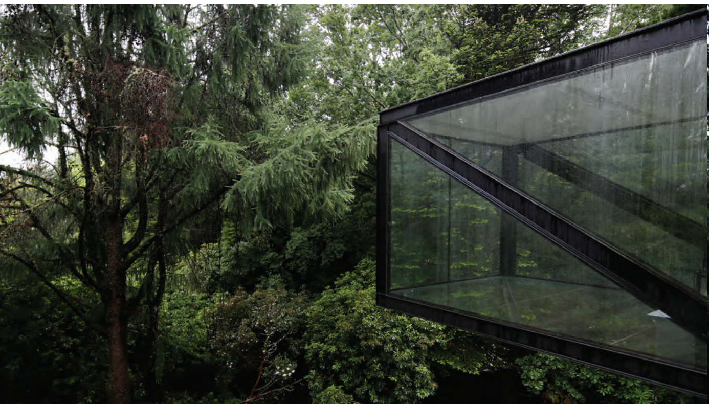
Imágenes del edificio después del incendio, fachada longitudinal y detalles donde se aprecia la relación con el bosque.
