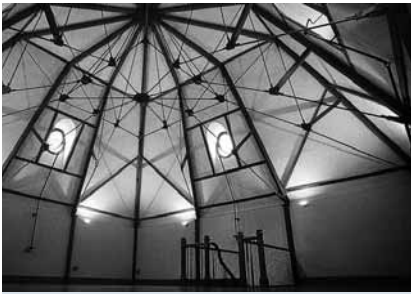
11 Figura 11. Alzado y vista interior del altillo en los torreones. Archivo Fundación Ferrocarril de Antioquia
