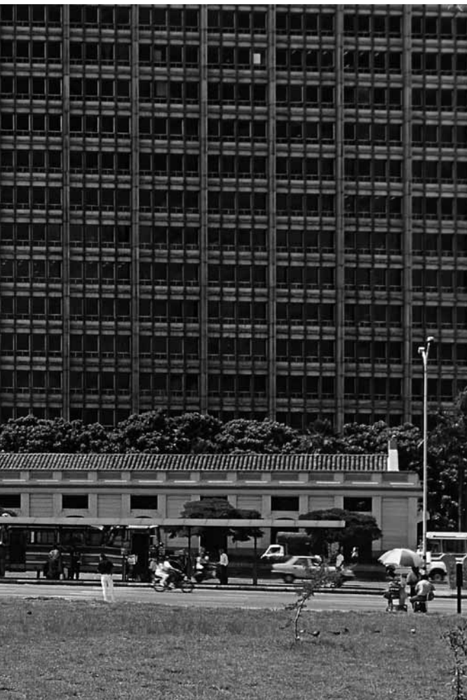
16 Figura 16. Vista general del conjunto Estación Medellín restaurado. Archivo Fundación Ferrocarril de Antioquia
