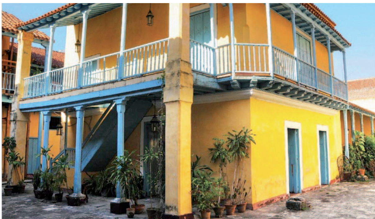
Figura 3. Columnas de madera como soporte de los techos. Fotografía: Raquel Carreras.
