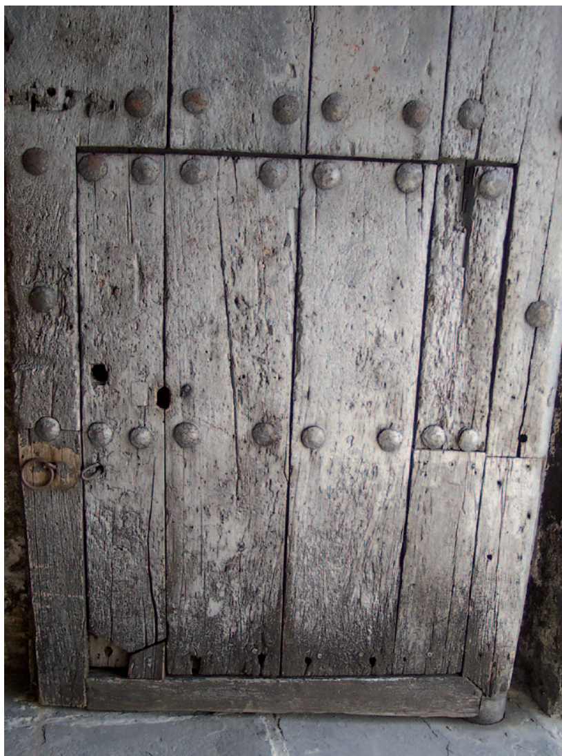
Figura 4. Puerta de fachada con tableros fijados mediante grandes clavos de hierro. Fotografía: Alina Cuza.
