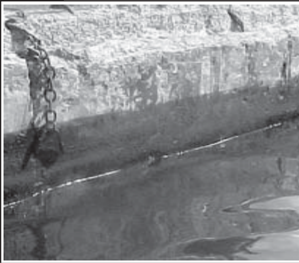
Fotografía 11. Aspecto del muelle antes del tratamiento.
