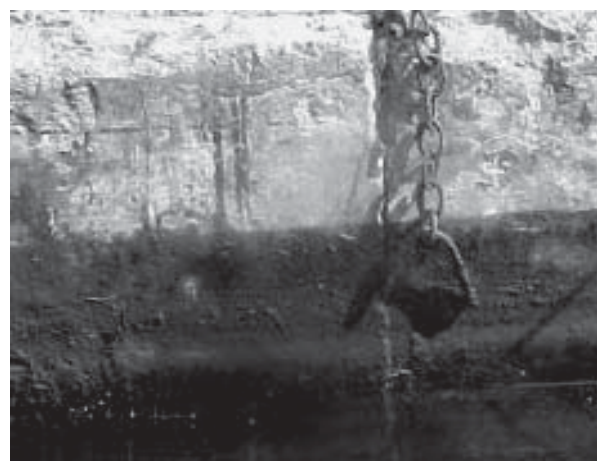
Fotografía 9. Aspecto del muelle antes del tratamiento.
