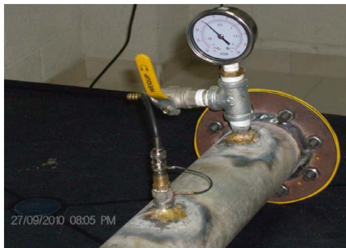
Figura 2. Montaje del enlace y preparación de la guía de onda
