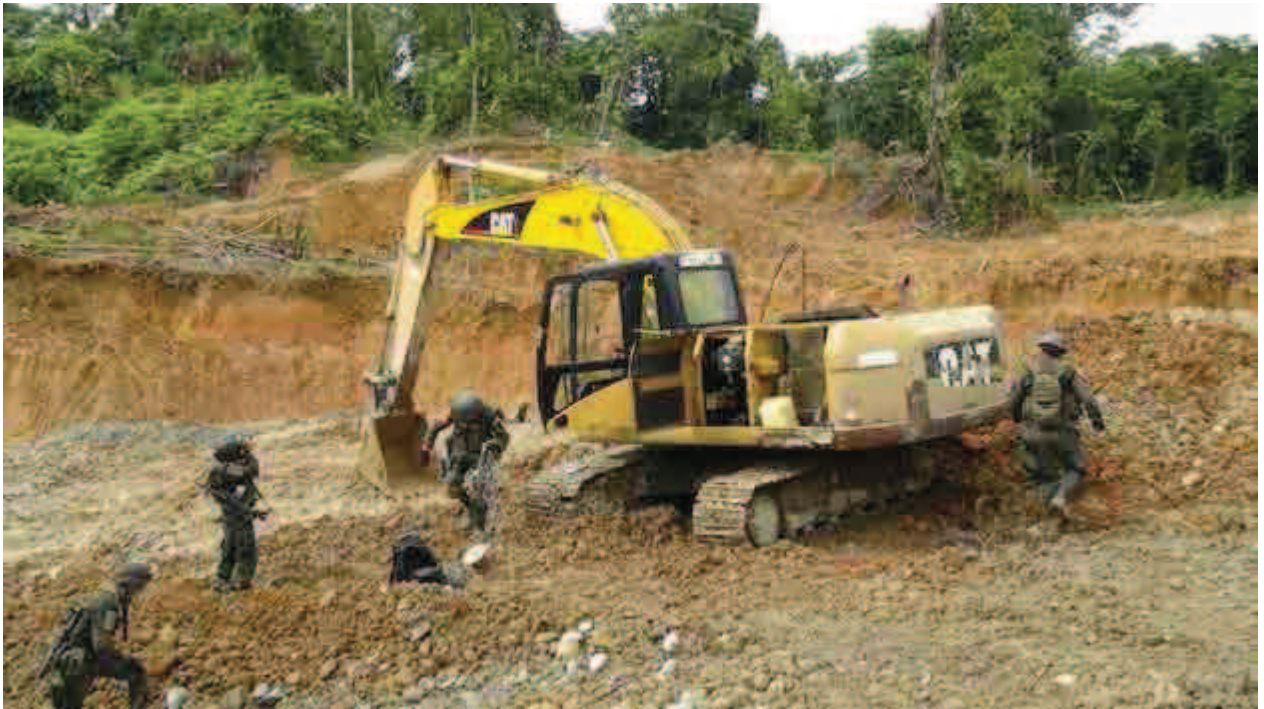
Fotografía 2. Dirección de Carabineros y Seguridad Rural (2013). Maquinaria pesada. Municipio de El Bagre.
