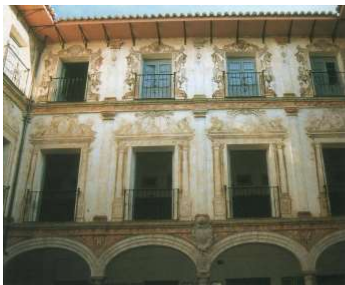
Fig. 14. Convento de San Felipe . Casa de Estudios, Patio. Málaga.
