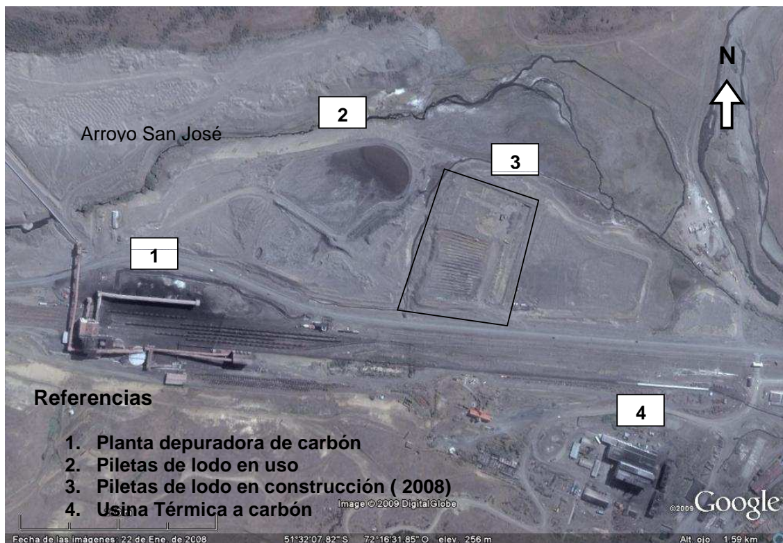
Fig.4. Piletas de decantación de lodos de planta depuradora de carbón. (Google Earth, 2008)
