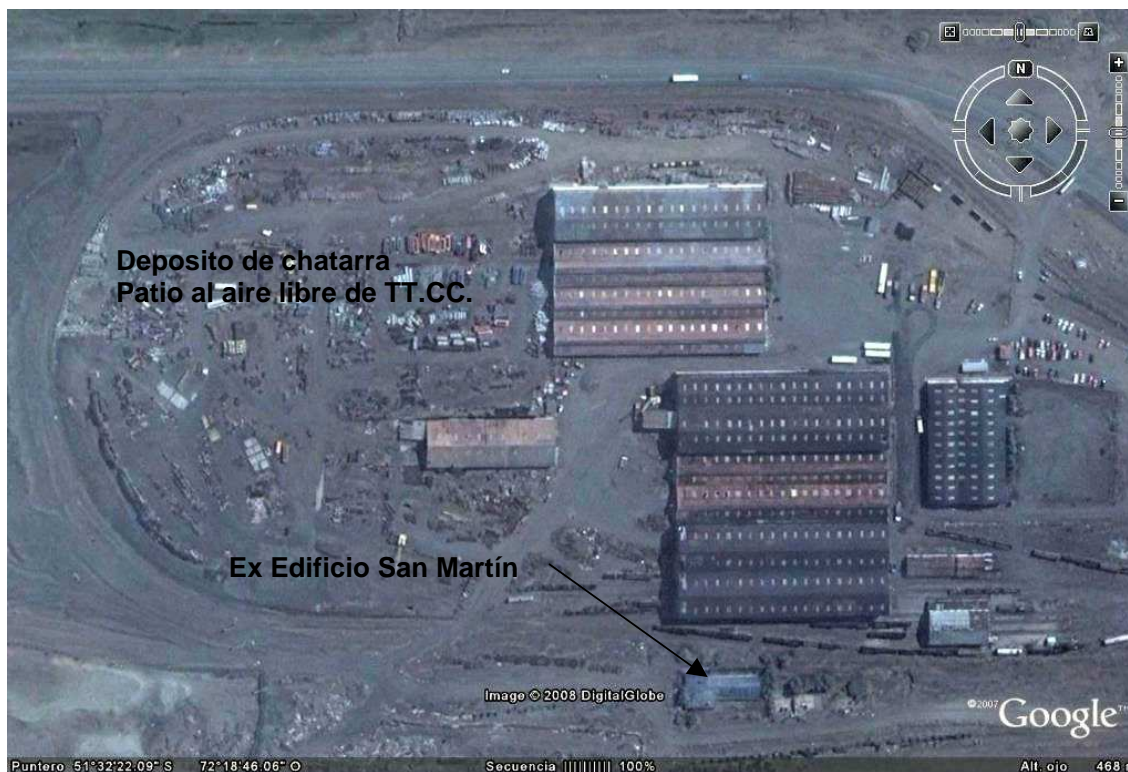
Fig.7. Aspecto del acopio de chatarra a cielo abierto, sector Talleres Centrales (Google Earth, 2008)
