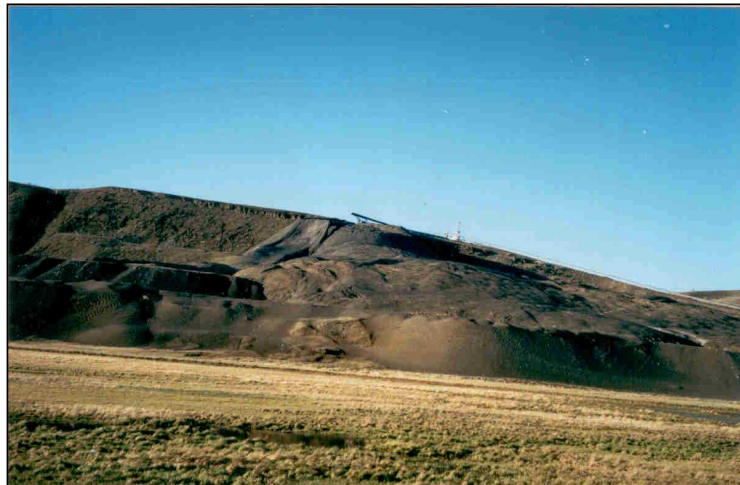
Figura 2: Depósitos de Estériles. En la parte superior, cabezal de cinta de la escombrera actual. En la parte inferior, terraplenes de antiguas descarga de estériles sobre el humedal San José.(Caballero A.,2004).
