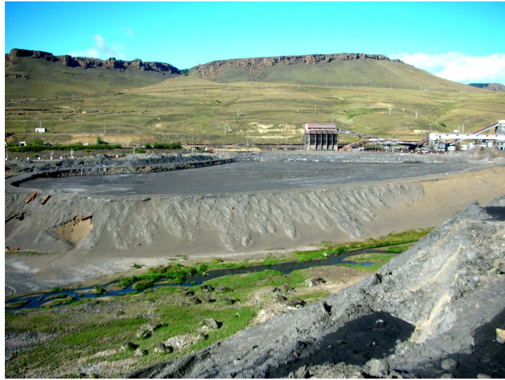
Figura 4: Vista de una pileta de lodos y terraplén.( Caballero A.,2008)
