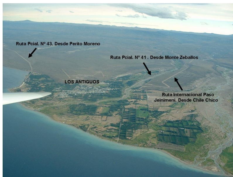
Fig. 5. Principales puntos de acceso a la localidad. Foto: Díaz, J.
