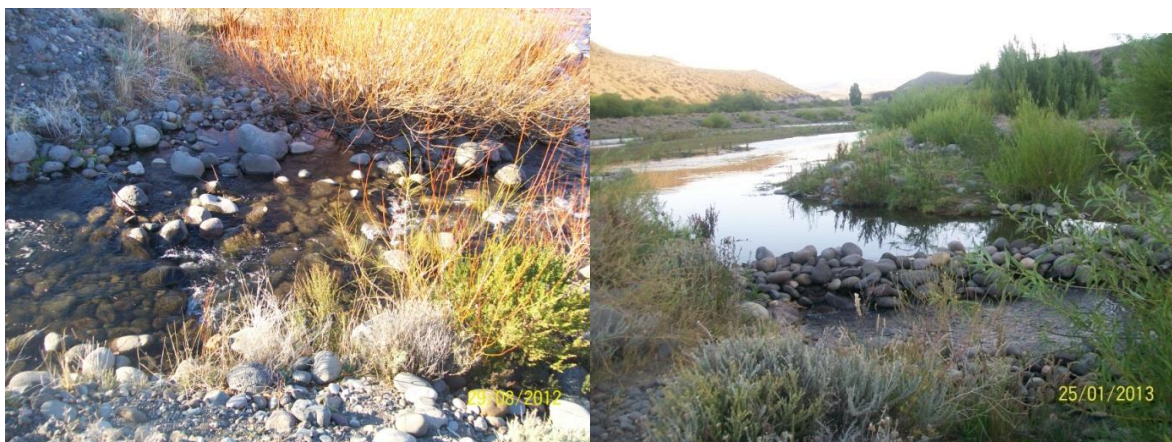
Fig. 21. Izq. Conexión del canal alternativo para remonte de los peces con el río en sus extremos inferior. Der. Interrupción del canal por acumulación de canto rodado. Foto: Díaz, J.
