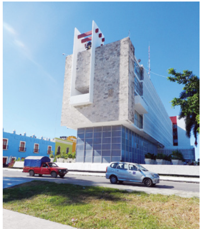
FIGURA 6. Edificio de los Poderes, ciudad de Campeche, Campeche, México: se puede observar que ya no conservan las escaleras con dirección a la plaza y que la planta baja ha sido cubierta (Fotografía: Raúl González Medina 2013).
