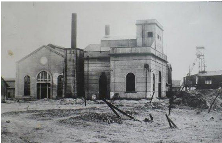
Figura 1 – Usina termoeletrica de Arroio dos Ratos em funcionamento (1935) – Poço Fraternidade (ou Poço 1) – CEFMSJ
