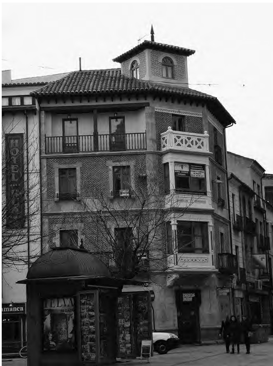
FIG. 2. Fachada del edificio de Roque Sagrado (1925). Confluencia de las calles Sánchez Barbero y Rúa Mayor.
