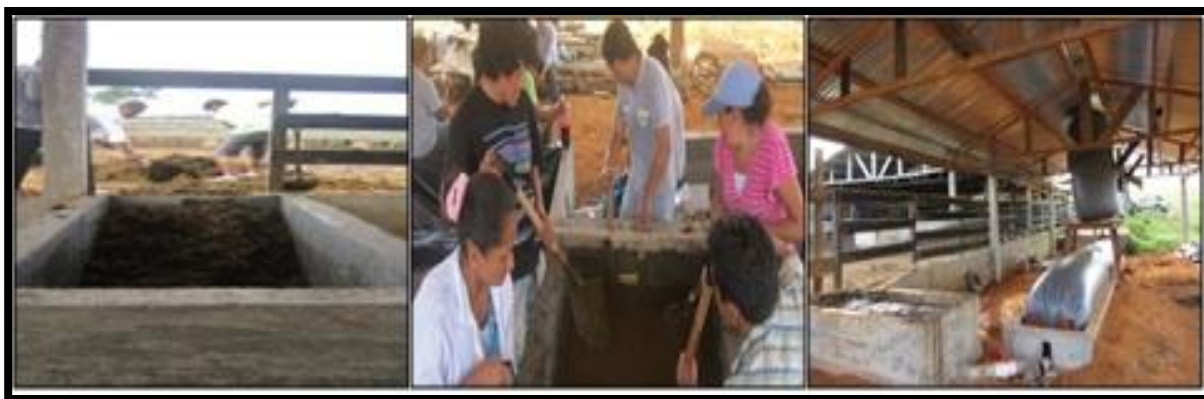
Figura 4. Construcción e instalación del estercolero y el biodigestor en su capacidad total de producción de gas metano. (Fuente: elaboración propia, 2013)
