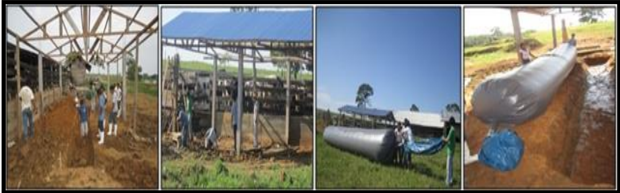
Figura 1. Proceso de construcción de la infraestructura que alberga al reactor de geomembrana de PVC. (Fuente: elaboración propia, 2013)
