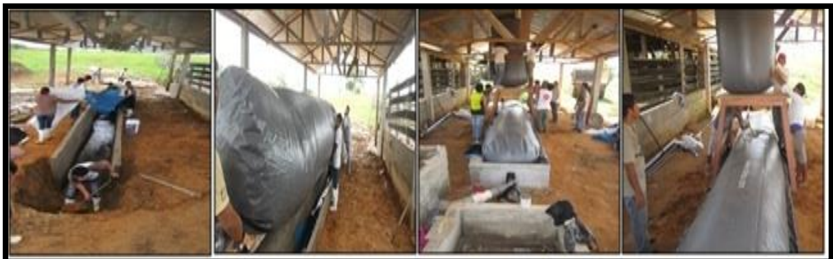
Figura 2. Instalación del reactor de geomembrana de PVC y el reservorio de gas metano. (Fuente: elaboración propia, 2013)
