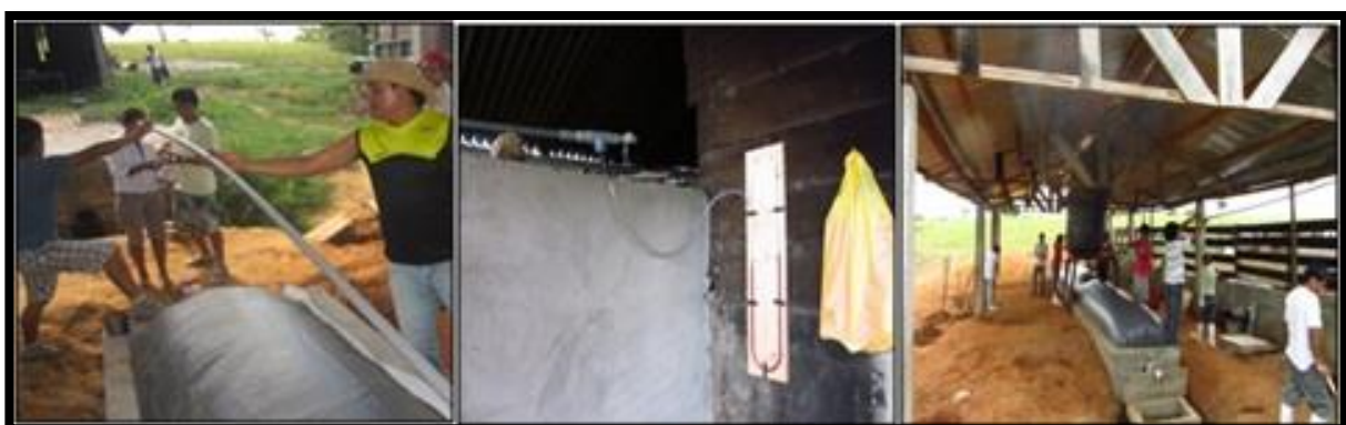
Figura 3. Instalación del sistema de transporte de gas metano hacia el manómetro y quemadores de la cocina a gas. (Fuente: elaboración propia, 2013)
