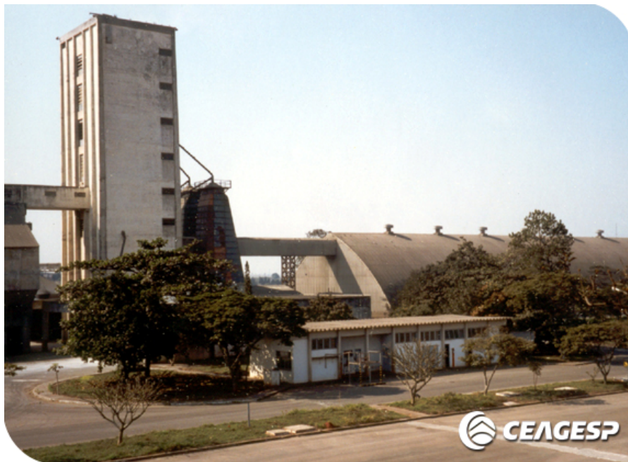
Figura 5: Terminal Intermodal de Tatuí.
