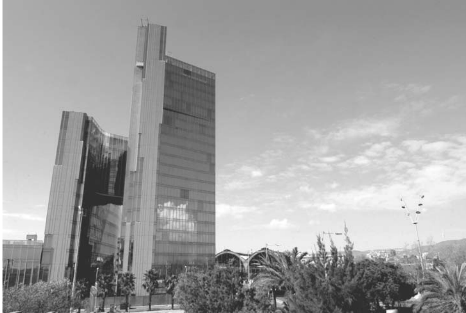
FIGURA 1 - TORRE MARENOSTRUM, SEDE DO GRUPO GAS NATURAL, BARCELONA, ESPANHA.
