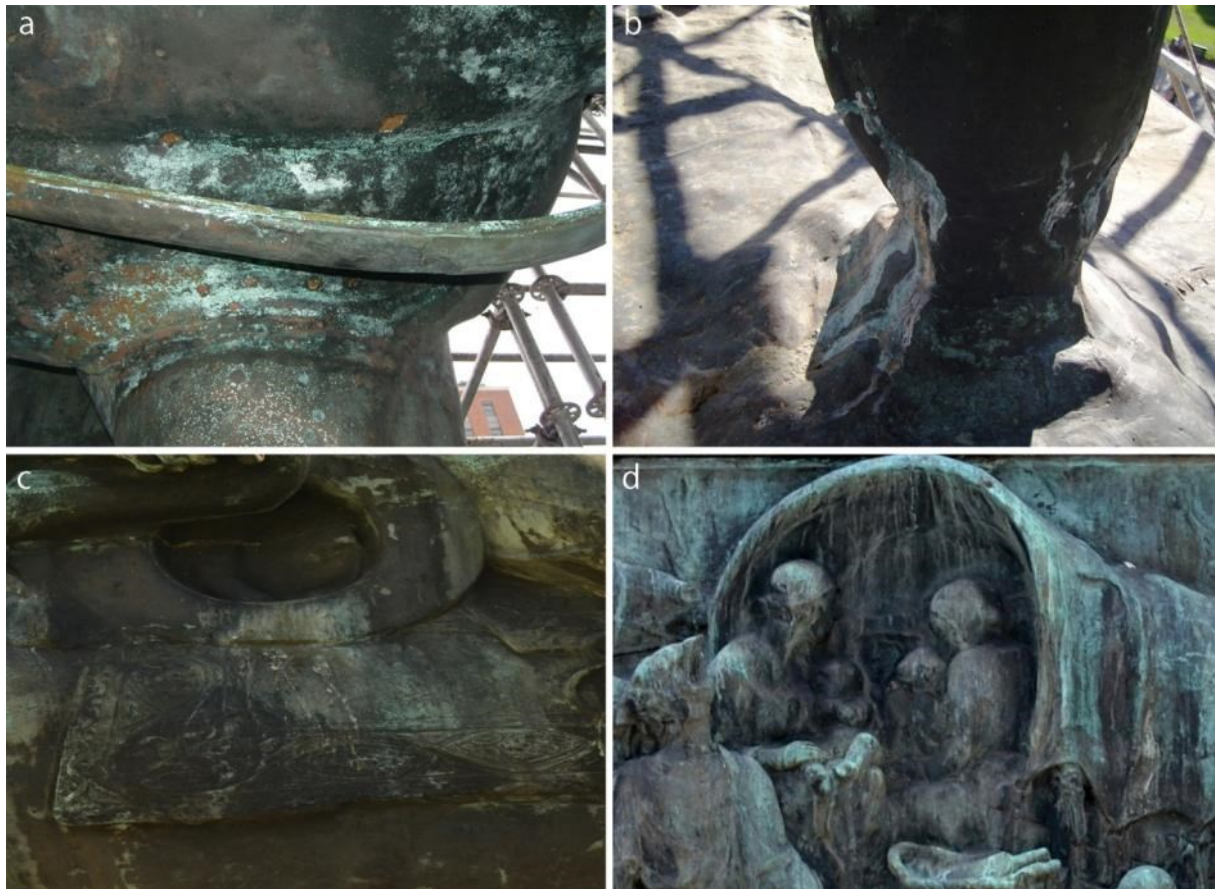
Figura 4. Diferentes corrosiones en el monumento: (a) cloruros activos tras varios días de niebla continuada, (b) corrosión en zonas que trabajan bajo tensión -grieta en la pata del caballo-, (c y d) corrosiones y líneas de lavado. ©Jimena Schroeder - Claudia Frigerio.
