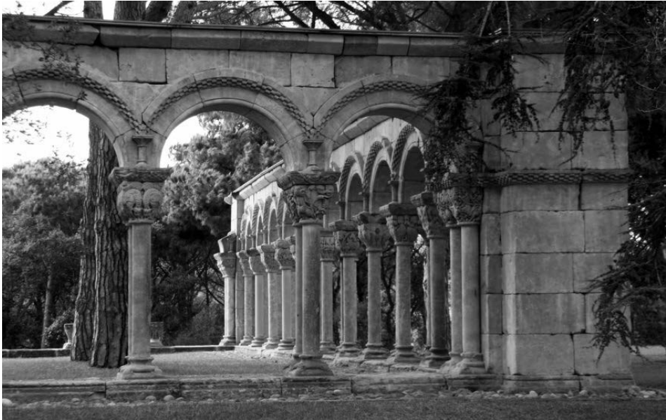
Fig. 3. Ángulo noroccidental del claustro. Mas del Vent, Palamós (Gerona). Fotografía de José Miguel Merino de Cáceres
