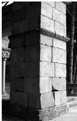
Fig. 7. Machón de esquina. Claustro de Palamós. Fotografía de José Miguel Merino de Cáceres.
