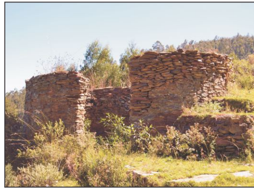
Figura 02: Vista frontal del edificio 02 en El Obraje 02, desde el este. Nótese la reconstrucción de los muros hacia su parte superior.
