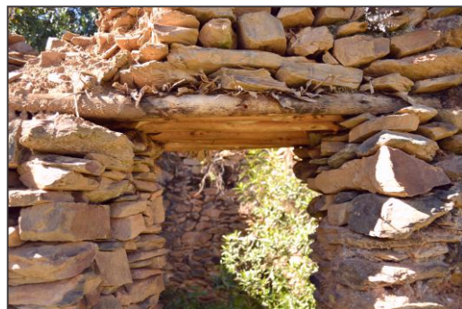
Figura 03: Detalle de la reconstrucción del vano de ingreso al edificio 09 en El Obraje 02. Nótese en el dintel el uso de ramas de eucalipto, árbol inexistente en tiempos prehispánicos en la región.
