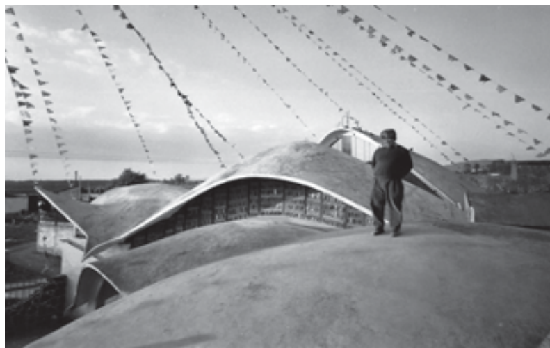
Foto 5a. El arquitecto mexicano Carlos González Lobo en las cubiertas de la iglesia de El Mirasol.
