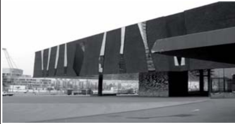
Foto 3a. Edificio construido para el Forum de las Culturas de Barcelona, en la zona del Poble Nou.
