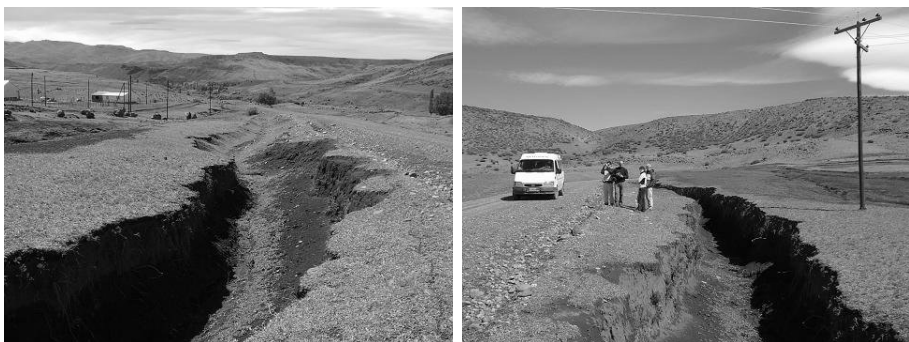
C y D. Cárcava activa dentro del Loteo planificado y al borde de la Ruta principal.
