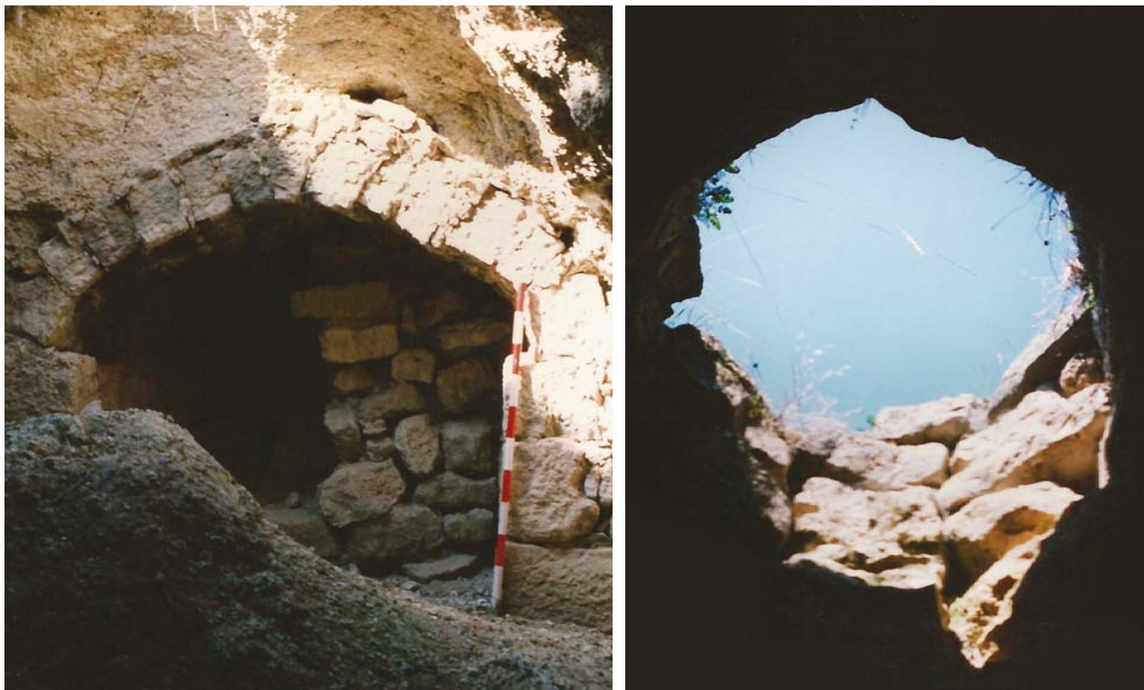
Entrada al refugio pastoril en 1998, y una de las dos chimeneas con las que contaba el complejo vista desde el interior.
