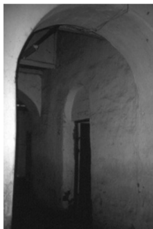
Fig. 6 Pasillo entre las salas norte y sur
