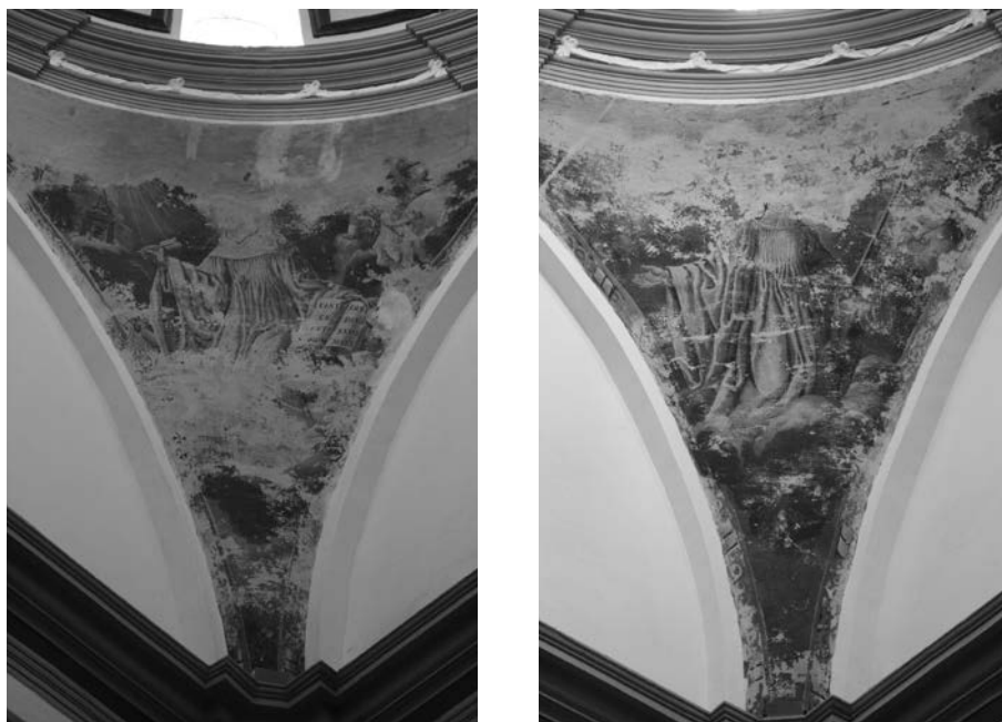
Pinturas sobre las pechinas. Escalera del Ayuntamiento de Fitero.
