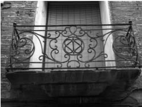
Balcón Calle Reja, nº 1. Casa Lizaso
