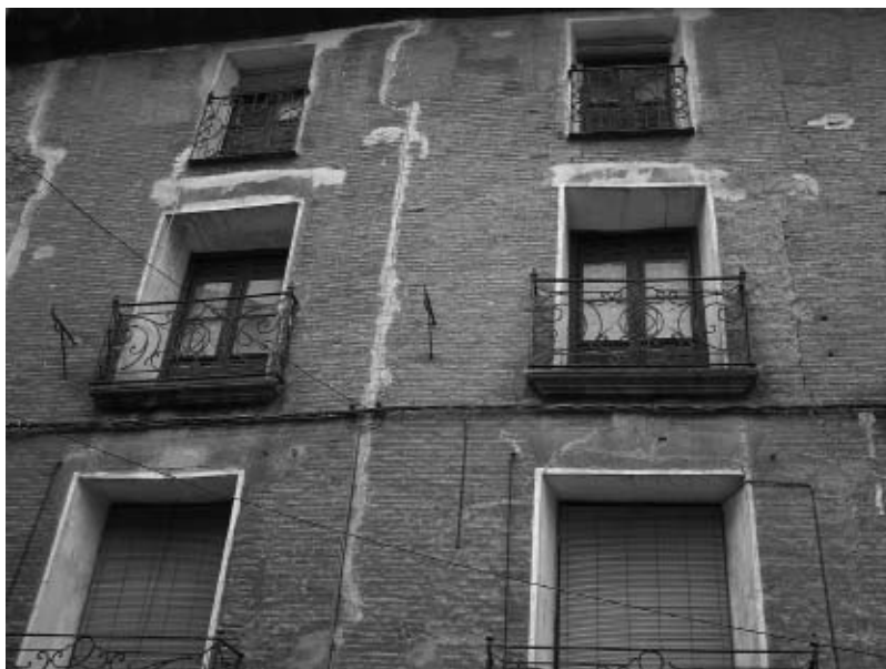
Fachada principal. Balcones centrales y elementos de forja
