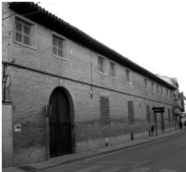
Buñuel. Casa de José Lizaso Guendulain. Fachada principal. (Hoy Ramírez de Arellano)
