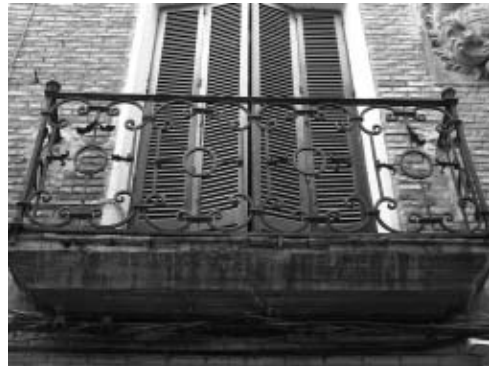
Balcón Calle Mayor nº 35
