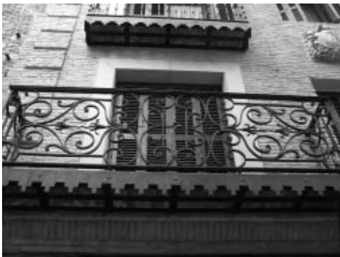
Balcón Calle Mayor nº 37
