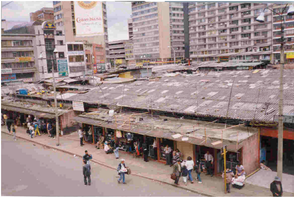
Foto 1: Las Galerías Antonio Nariño y el comercio informal aledaño antes de los desalojos de 1999. Fuente: Empresa de Renovación Urbana.
