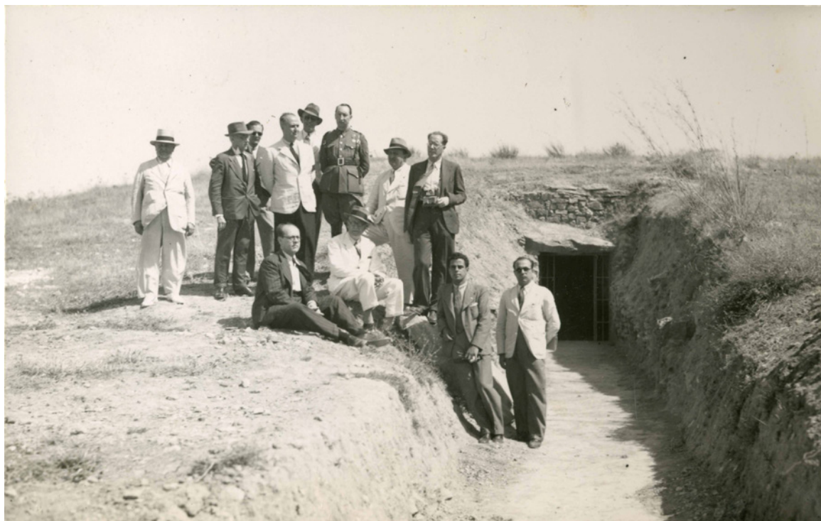
Lám. 7. Inauguración de las obras de restauración del dolmen de El Romeral. Manuscrito en el anverso de la fotografía: Asistentes: Julio Martínez Santa-Olalla, - Ilmo. Sr. Comisario General de Excavaciones Arqueológicas, = Manuel Navarrete, Delegado Gubernativo, = Comandante G. Civil = D. Luis Moreno, Alcalde Antequera = D. Manuel Fernández [José María Fernández Rodríguez], cronista de la Ciudad de Antequera = D. [espacio en blanco] Periodista = D. José García Berdoy, Presidente de la Sociedad Azucarera Antequerana, = D. José García Carrera = D. Juan Tembury Comisario de Zona de B.A. = Sr. Saenz, = Simeón Giménez, Comisario Provincial de Excavaciones Arqueológicas = Guarda del Monumento. Fotografía de Simeón Giménez Reyna, 17 de agosto de 1940. Archivo del CADA.
