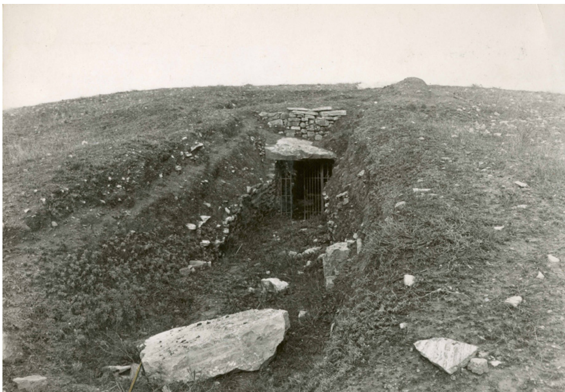
Lám. 6. Vista de la entrada al tholos de El Romeral con anterioridad a la restauración realizada por Francisco Prieto Moreno. Fotografía de Simeón Giménez Reyna, 1940. Archivo del CADA.
