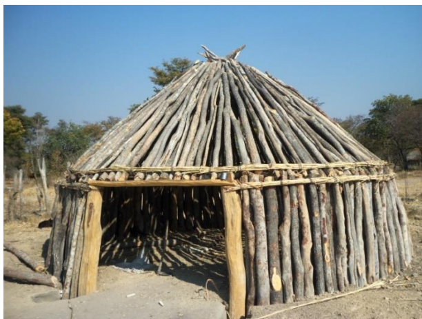
Figura 15 6. Fase da construção de uma casa de pau-a-pique
