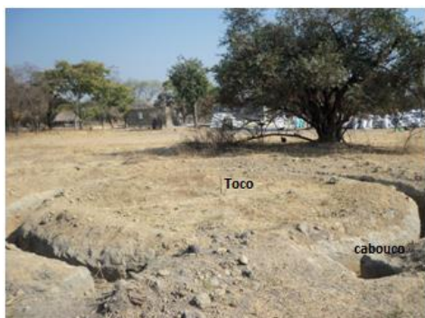
Figura 12 4. Marcação de uma casa de pau-a-pique
