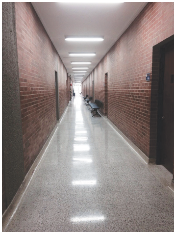
Fig. 11. Vista sur pasillo Bloque E quinto piso Fuente: Autores
