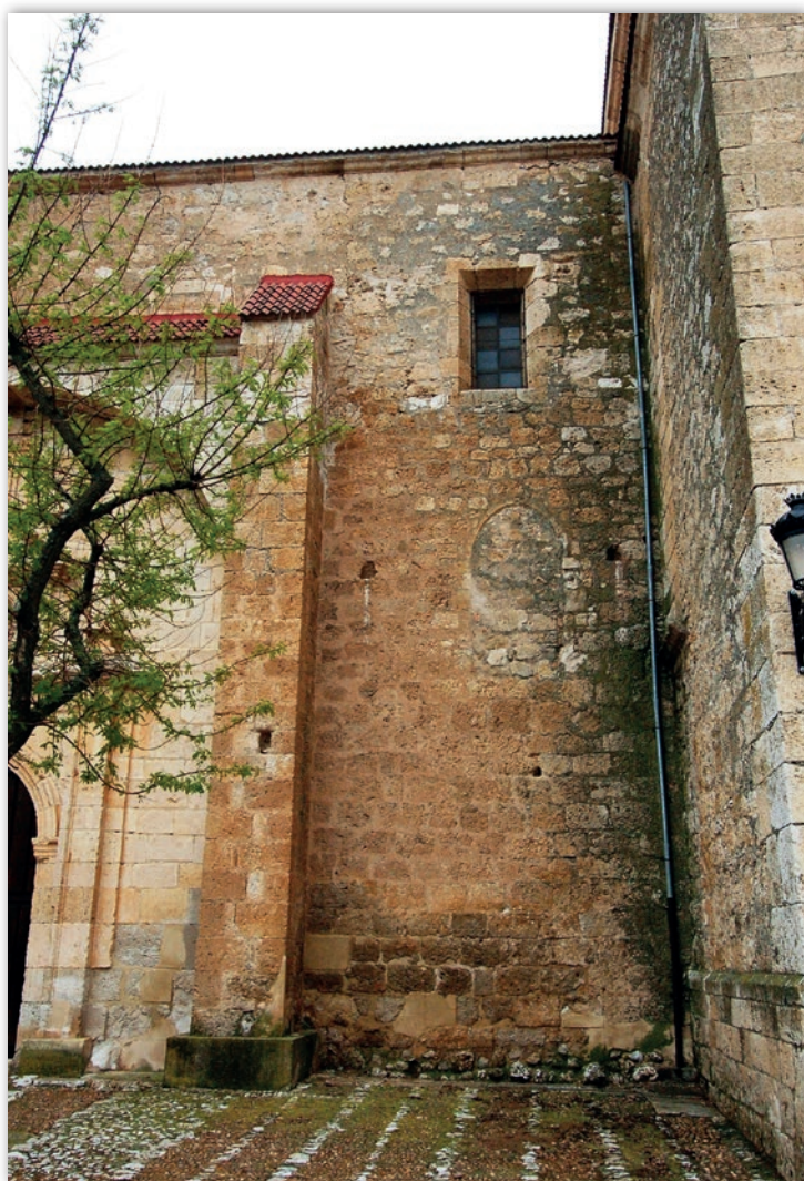
Fig. 5.- Primer tramo de la nave medieval de la iglesia de Nava de Roa, son su buco ojival tapado y el recrecido hasta la cornisa del siglo XVIII.
