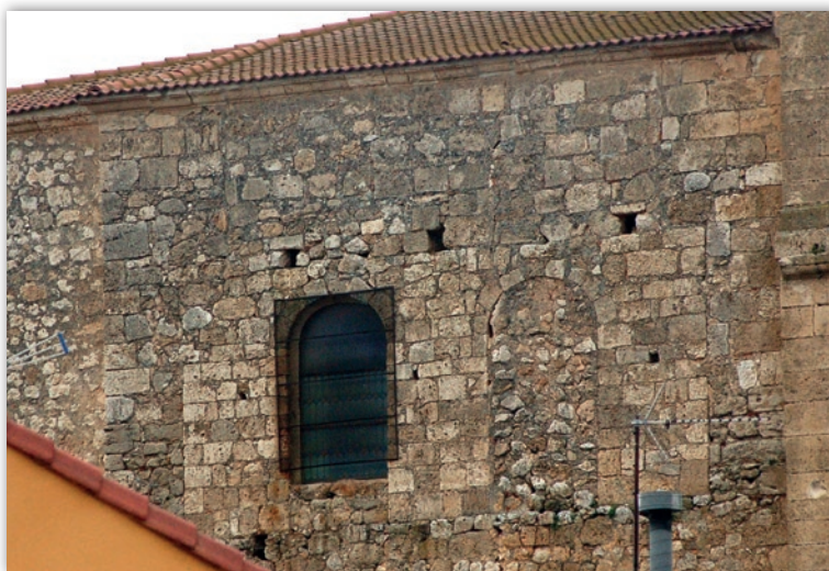
Fig. 4.- Nava de Roa. Muro occidental de la nave, donde se aprecian los huecos de la espadaña embutidos en el recrecido del muro.
