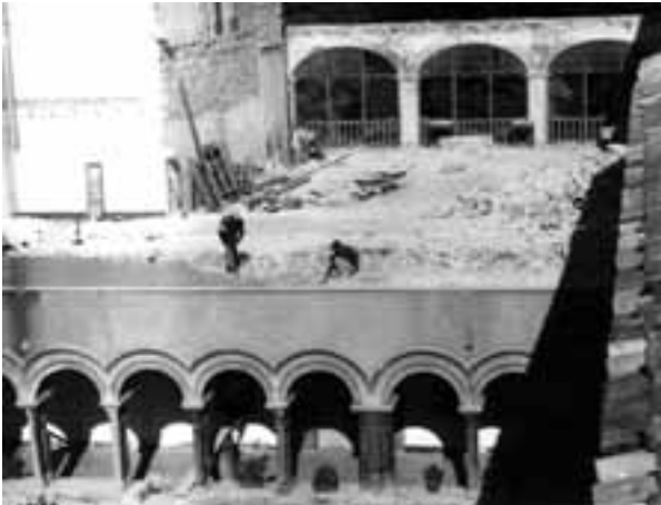
Fig. 6. Obres de reforma del monestir de Bellpuig de les Avellanès als anys setanta del segle xx. Es pot apreciar com ja s'ha destruït la teulada i distribució interna de les estances del canonge Jaume Pasqual. Foto: Arxiu del Monestir de Bellpuig de les Avellanès (AMBA).
