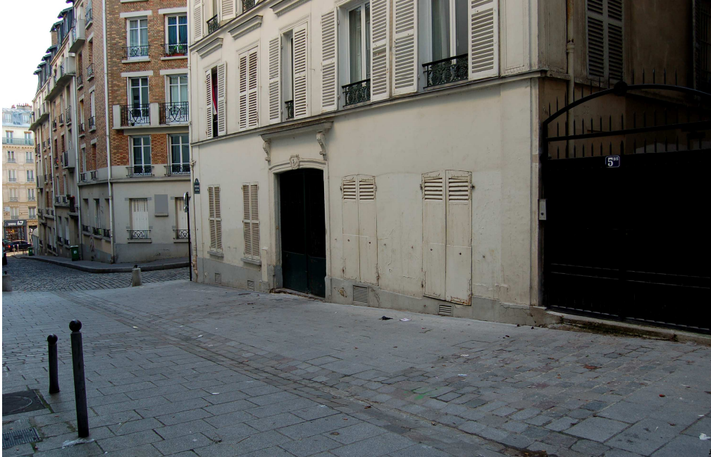
Fig. 2. Estado actual de la pared. Passage Cottin. © Foto Mónica Tovar
