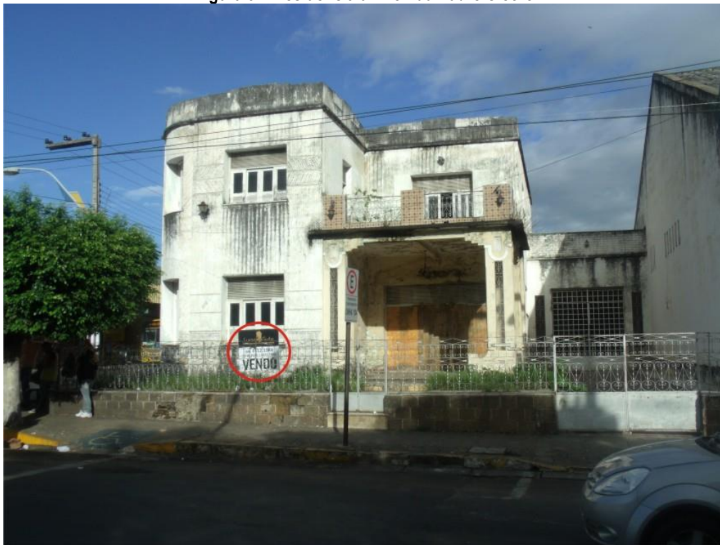
Figura 3 – Residência à Avenida Padre Cícero
