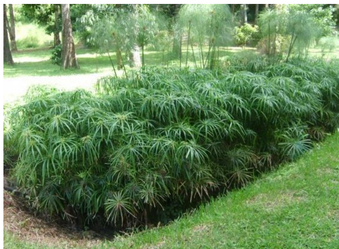
Figura 1. Humedal construido de flujo subsuperficial horizontal en la empresa farmacéutica
