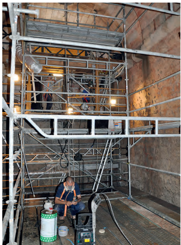
(Figura 5) Rehabilitación del Patrimonio Material: Uno de los aljibes de Felipe II.
