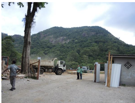
Imagem 11 - Avanço das Obras da Cyrela
