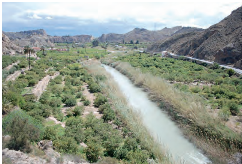
Fig. 4. Sistema de terrazas, a ambos márgenes del río, en el tramo entre el Salto de la Novia (Ojós) y Ulea.
