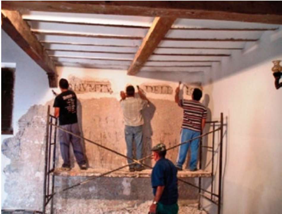
Fot. 4. Obreros interviniendo en la recuperación de las pinturas de la pared de la epístola
