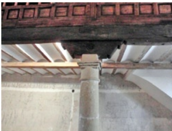
Fot. 3. Zapata central sobre columna toscana
