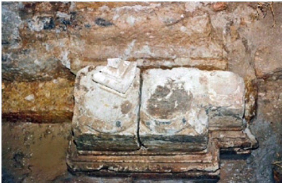
Fig. 15. Triple basa de pilastra sobre plinto en el ángulo este, visible en el interior de la ermita
