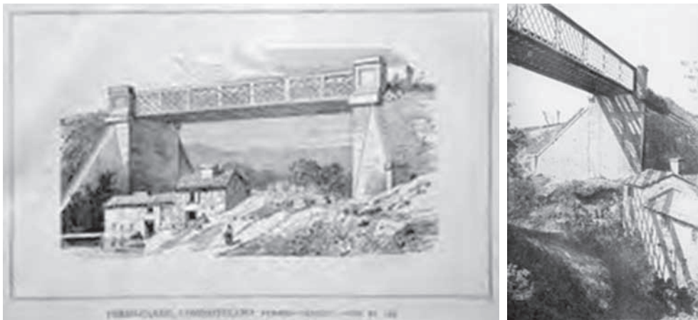
Figuras 13 e 14. Ponte sobre o río Sar. Fonte: Ferropedia
