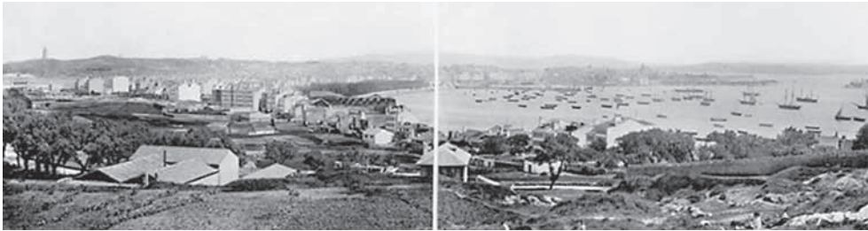
Fig. 26. Vista xeral da periferia da cidade da Coruña na época. Fonte: Biblioteca Nacional
