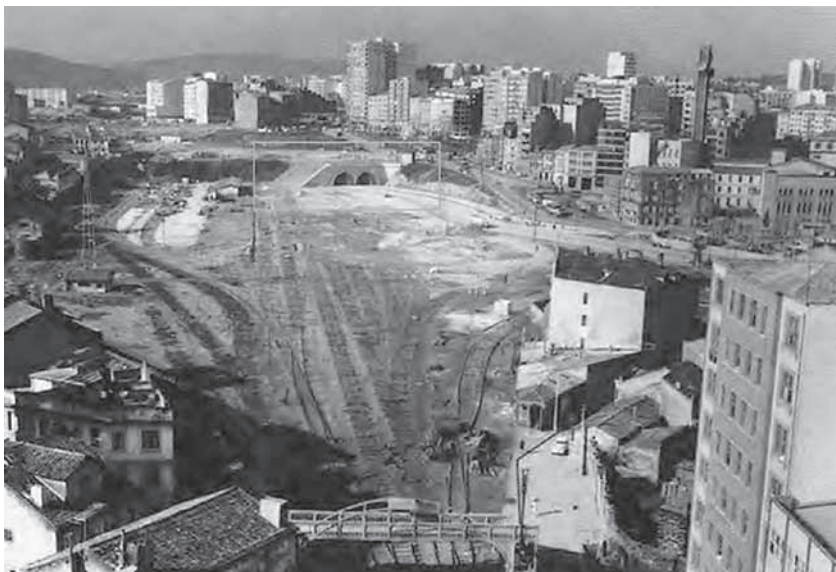
Fig. 66. Desmantelamento de vías da estación de Norte e túneles da avda. Salgado Torres. Fonte: arquivo La Voz de Galicia
