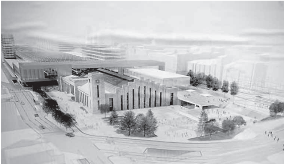
Fig. 77. Vista panorámica da nova estación da Coruña. Fonte: César Portela + IDOM / ACXT
