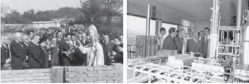
Figuras 43 e 44. Colocación da primeira pedra en Balaidos (1958) e inauguración da refinería de Bens (1964) Fontes: PSA Peugeot-Citröen Vigo e Axencia EFE respectivamente
