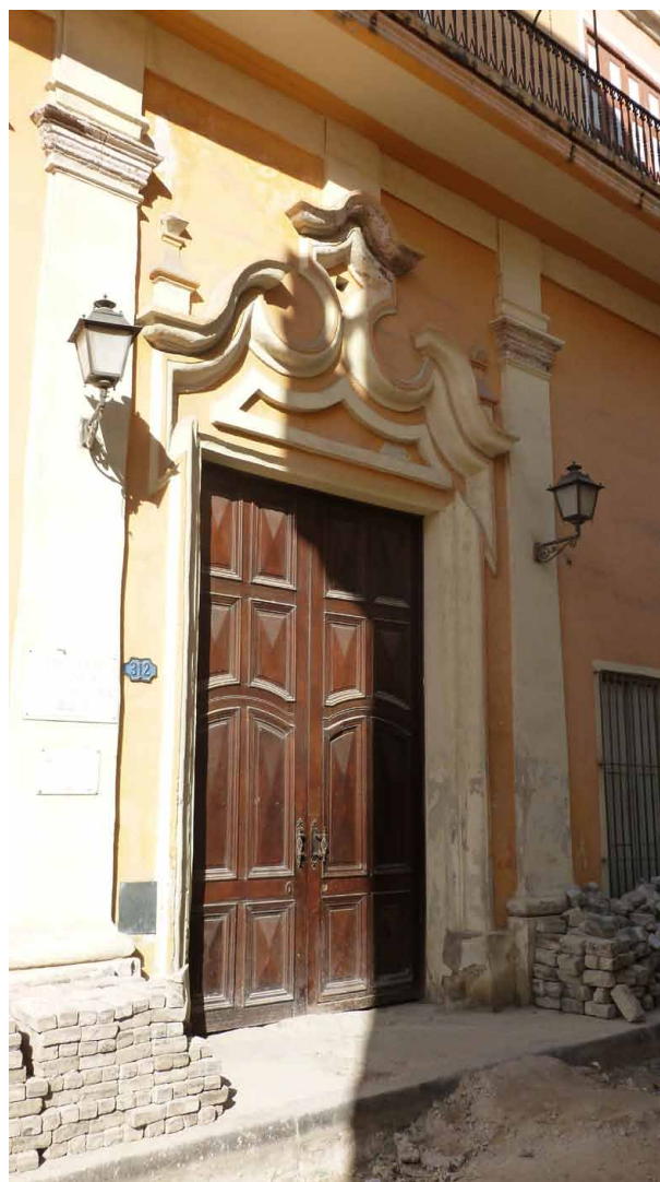
Fig. 3. Portada de la casa del marqués de Casa Calderón. Oficios 312.
