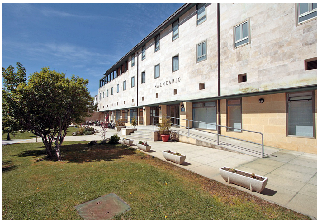
Figura 6. Baños de Montemayor. Balneario nuevo.
